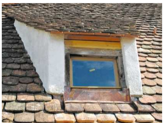
Bayerischer Prachtbau: das Kloster Benediktbeuern (oben). Bei der energetischen Sanierung der Alten Schäferei des Klosters (links) wurden der barocke Dachstuhl, seine Ziegeldecke und auch die Schlepplagen mit historischem Material wiederhergestellt. Nur die Fenster sind neu
